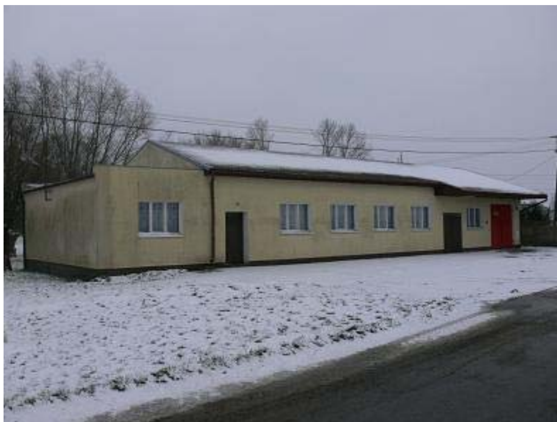
Rysunek 8.2. Świetlica wiejska w Borzysławiu - widok z zewnątrz
